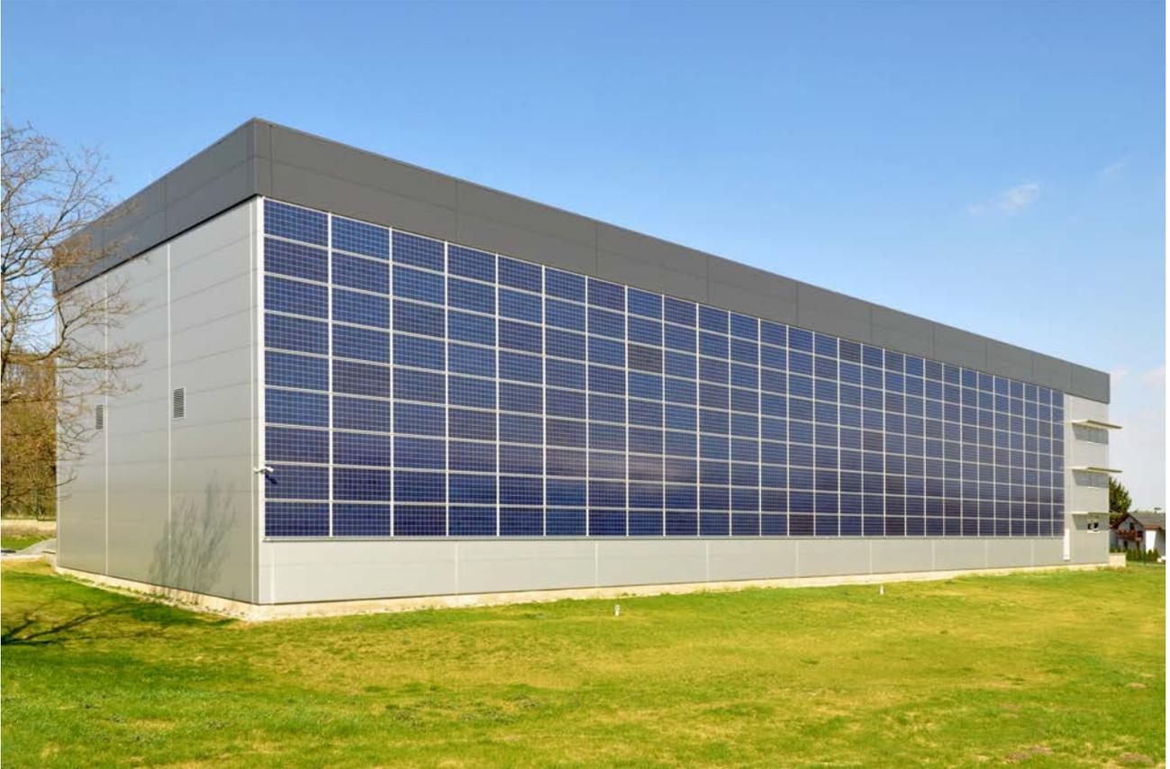
En lo referente al diseño arquitectónico, la fachada adquiere una estética muy ordenada y pulcra, gracias al perfecto ensamblaje que se logra entre los paneles, un diseño poco común difícil de conseguir con otros materiales.
